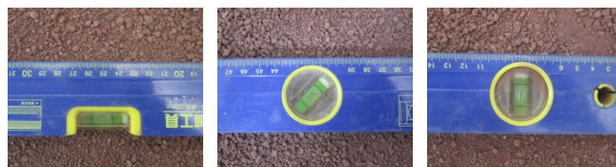
图11 地基平整度检测
